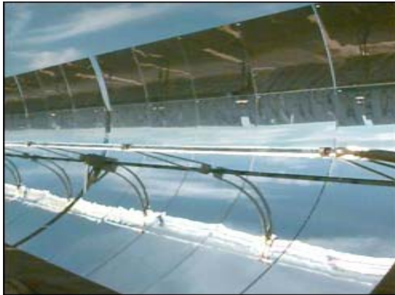
Abbildung 17: Parabolrinne mit Absorberrohr [32]
