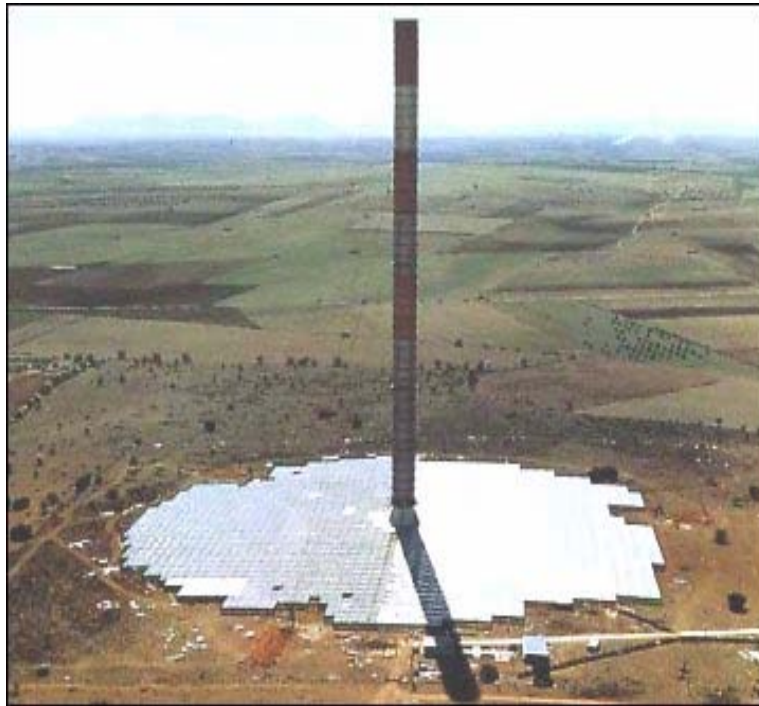
Abbildung 19: Aufwindkraftwerk bei Manzanares [32]
