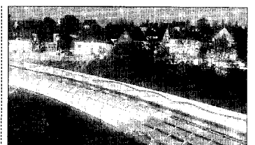
Puente sobre el valle Nesenbach en Stuttgart.
