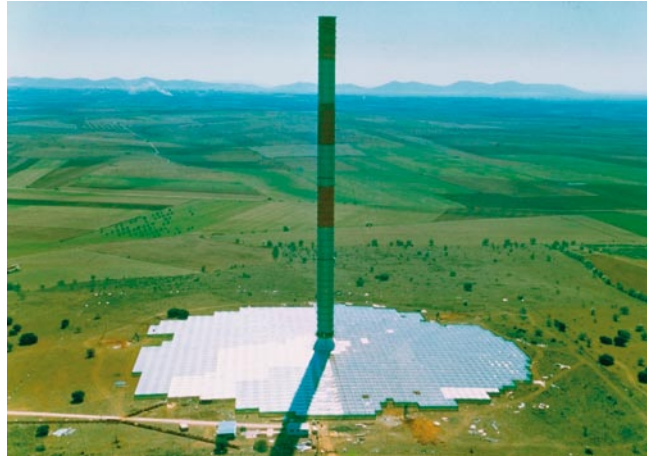
194 Meter hoch ragte der Kamin der Aufwindkraftwerk-Versuchsanlage aus der spanischen Wüste bei Manzanares. Die Idee dazu entwickelte 1931 der Technikautor Hanns Günther in seinem Buch „In 100 Jahren“
