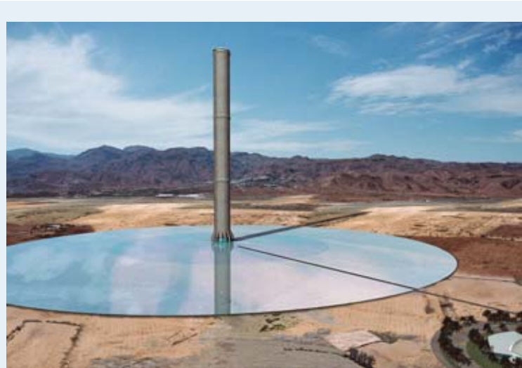
Höhe 1.000 m, Durchmesser 7.000 m - Simulation für ein Aufwindkraftwerk, 2007 © Braake, Grobe, Stuttgart
