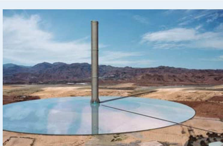
Höhe 1.000 m, Durchmesser 7.000 m - Simulation für ein Aufwindkraftwerk, 2007 © Braake, Grobe, Stuttgart
