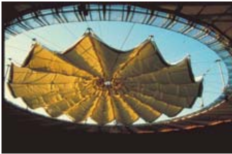
AdK_Schlaich-Berg_Saragossa 1-4 Wandelbares Dach der Stierkampfarena, Saragossa, Spanien, 1990 © Foto: Schlaich, Bergemann und Partner, Stuttgart
