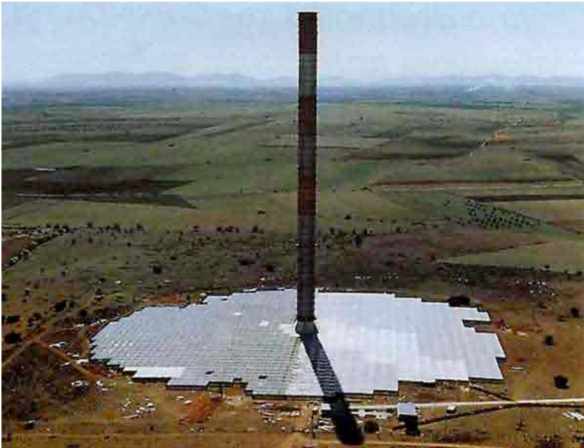
**Ein Aufwindkraftwerk ist ein Solarkraftwerk, welches unter der Ausnutzung des Kamineffektes eine Luftströmung über einer Windturbine zur Energieerzeugung nutzen kann. Dabei wird Luft durch die Sonne unter einem riesigen Glasdach erwärmt. Durch die Formgebung des Glasdaches wird die erwärmte Luft einem Kamin zugeführt. Im Kamin wird die Energie der Luftströmung durch eine Turbine in eine Drehbewegung umgesetzt und damit ein Generator zur Stromerzeugung angetrieben.**
